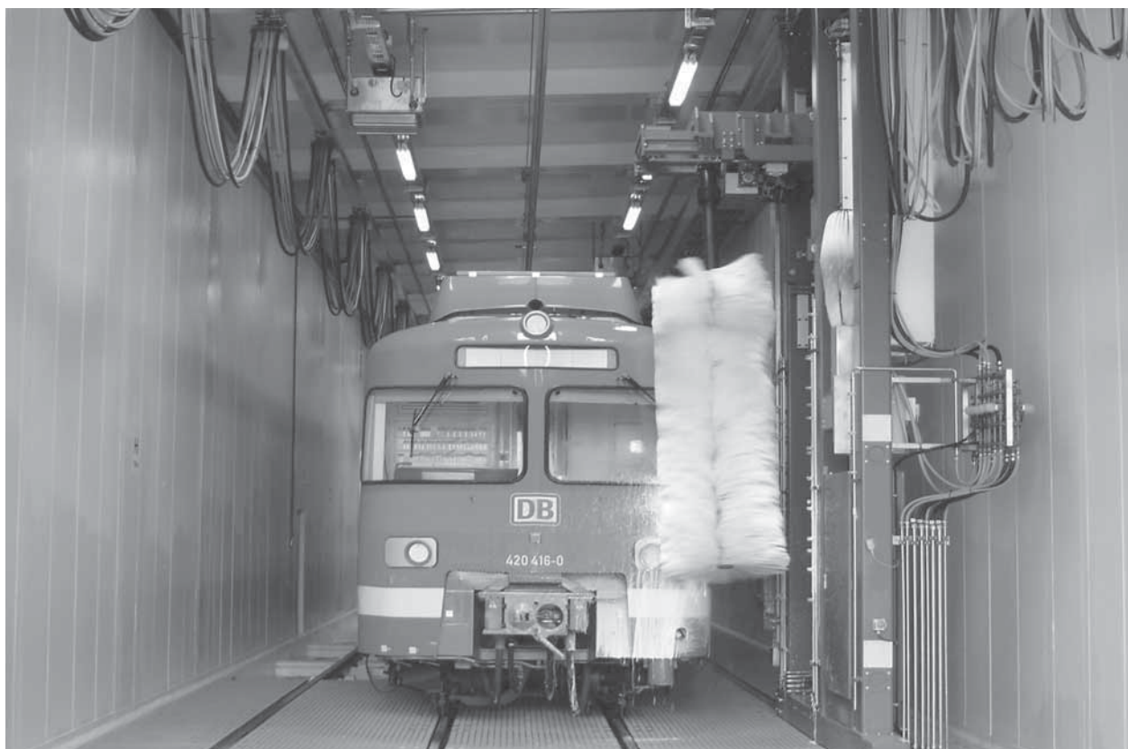
Chariots porte-câbles dans une installation de lavage de tram
